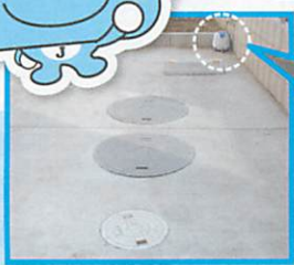
浄化槽のマンホール部分
